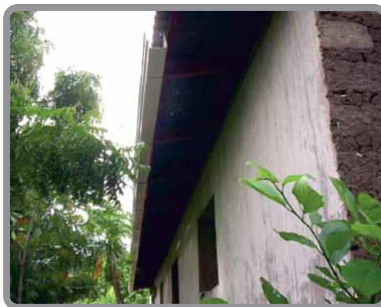
Figura 6. Captación de agua de tejados
