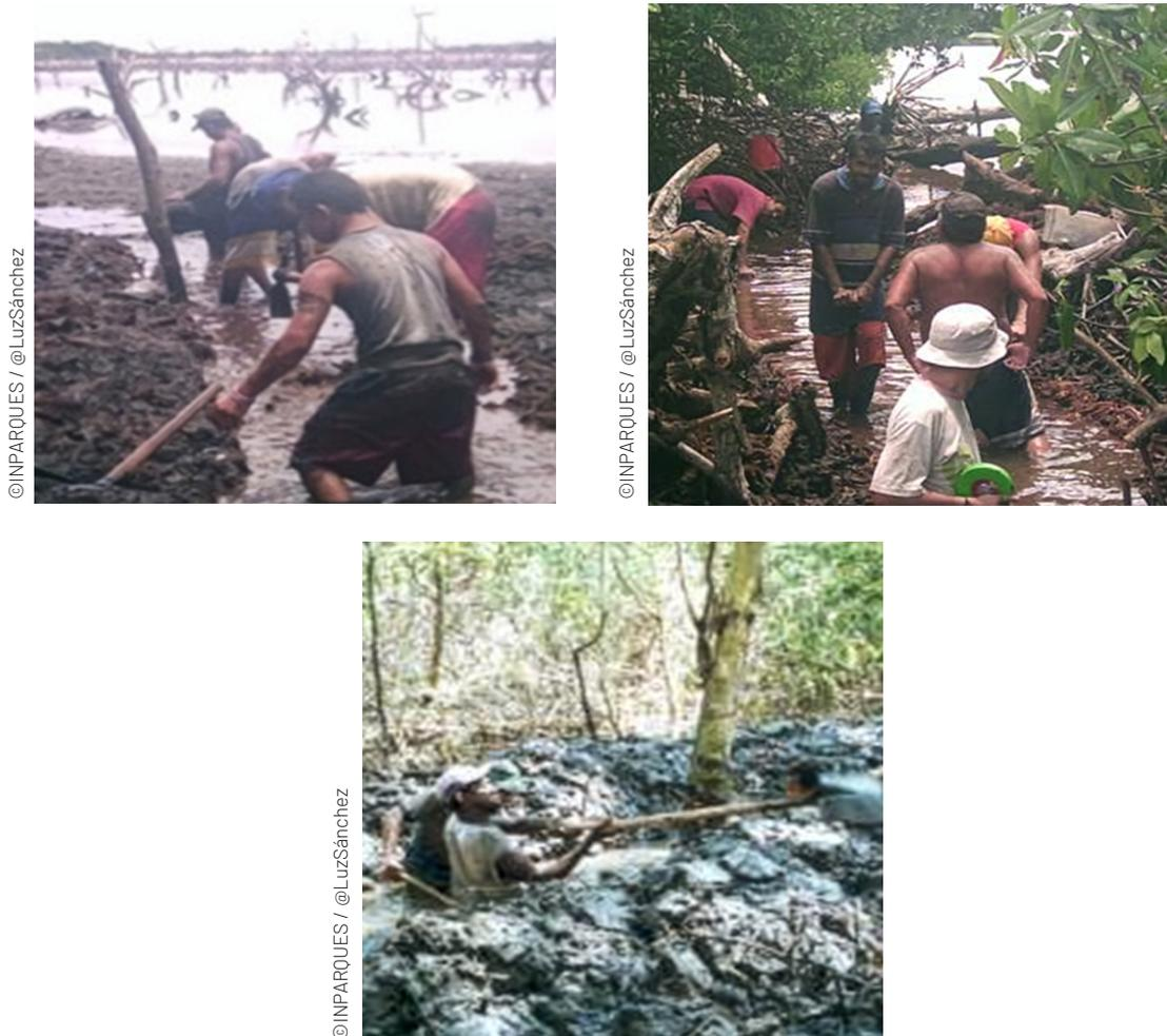
Para limpiar el canal primario se recomienda seguir las dimensiones naturales (ampliar el ancho de un canal disminuye la presión hidráulica y trae como consecuencia procesos de sedimentación). Por lo general, los canales en las áreas de manglar poseen dimensiones que van de 1-3 m de ancho y 1-2 m de profundidad. También se deberá remover todo el material que se encuentre en el fondo del canal.
