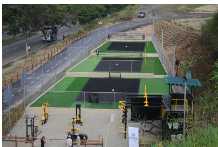
As instalações foram construídas com material 100% reciclado
